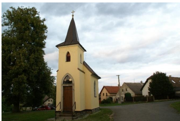
Obrázek 7 Oprava kapličky v obci Proseč
