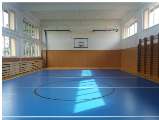
Obrázek 5 Rekonstrukce tělocvičny ZŠ Želiv
